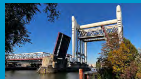
Vervanging en renovatie Verkeersbrug
