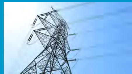
Hoogspanningsstations - Energie Zeebrugge partnerschap ELIA
