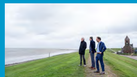
Dijkverbetering Koehool Lauwersmeer
